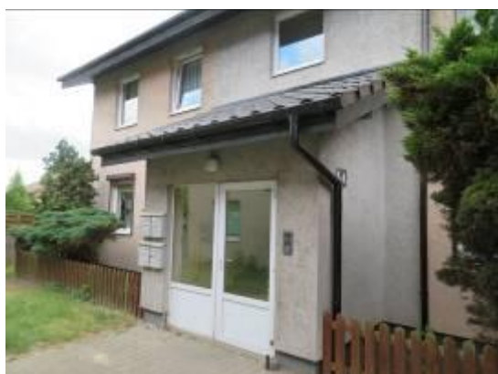
Wejście do budynku.
