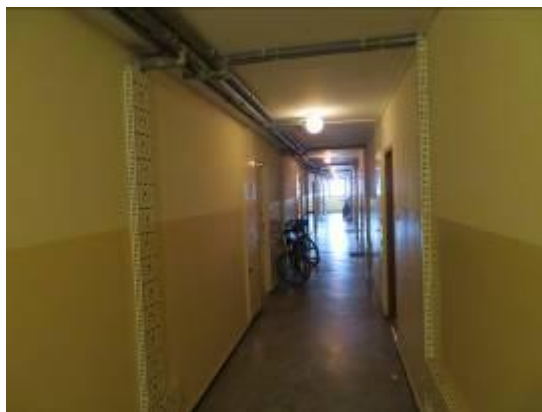
Korytarz klatki schodowej.
